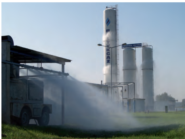
Fot. 8.1. Sprawdzenie instalacji zraszczowej zgodnie z założeniami WPO-R
